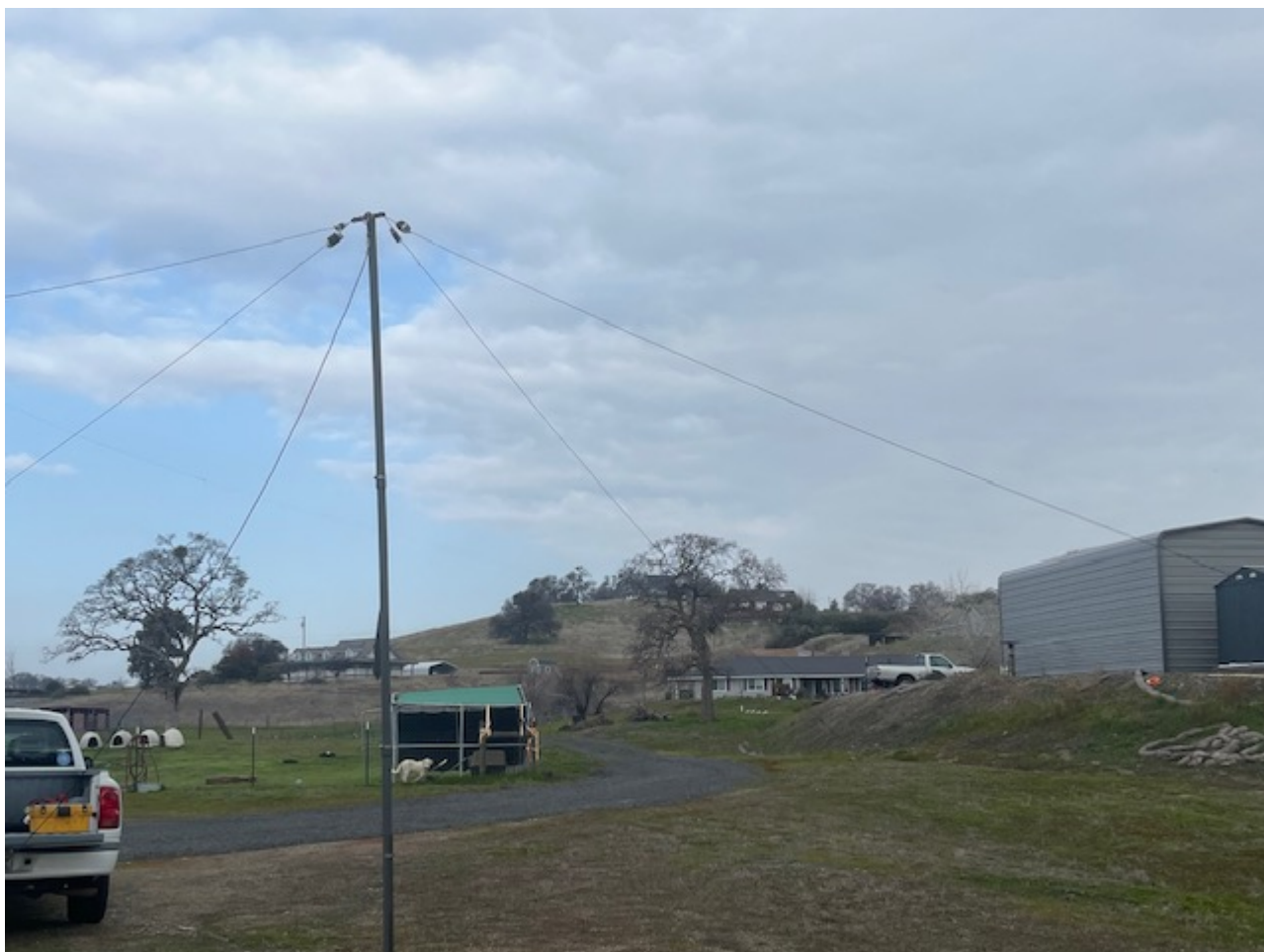
N6AXQ , NVIS Antenna
