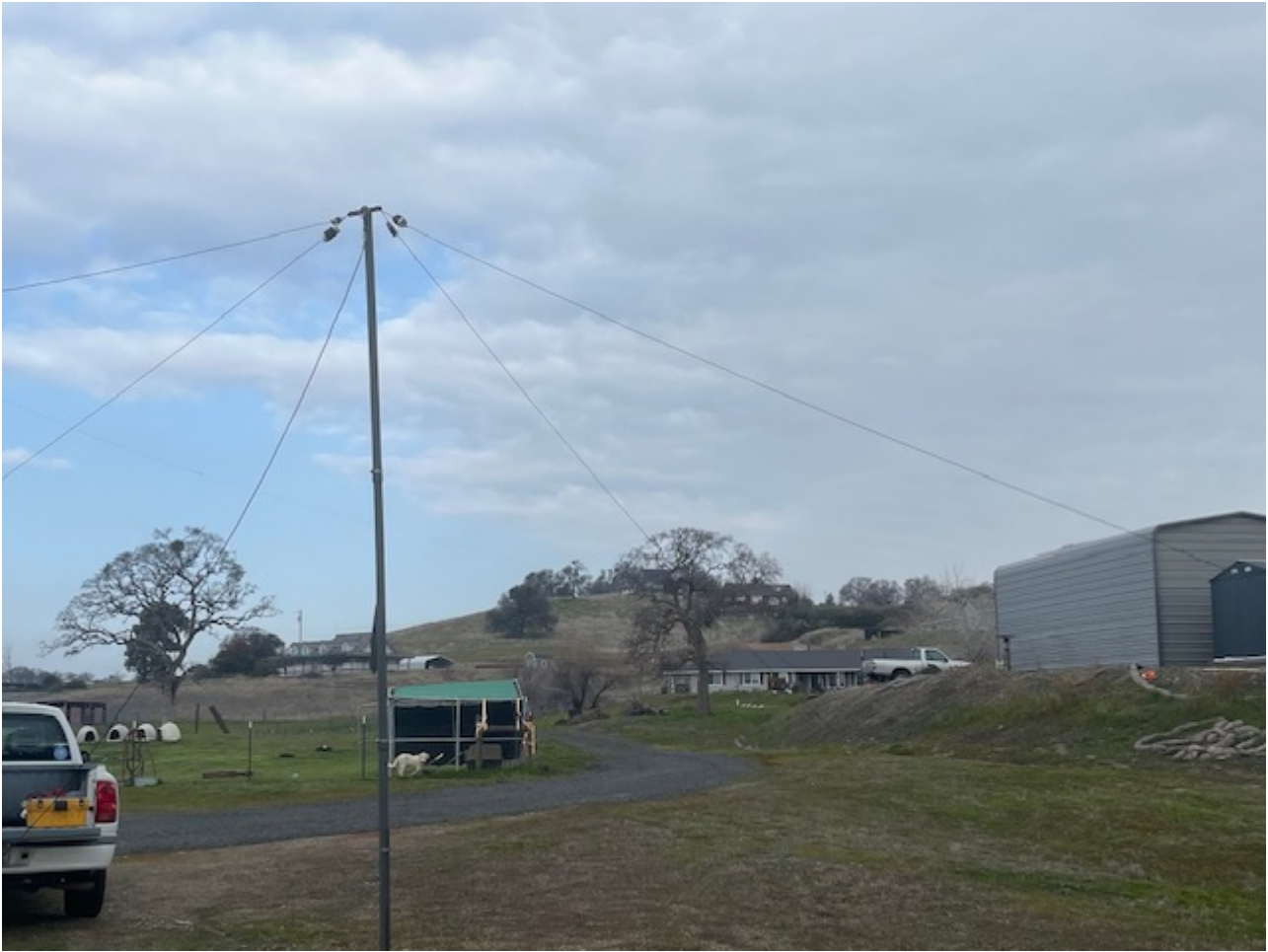
N6AXQ , NVIS Antenna
