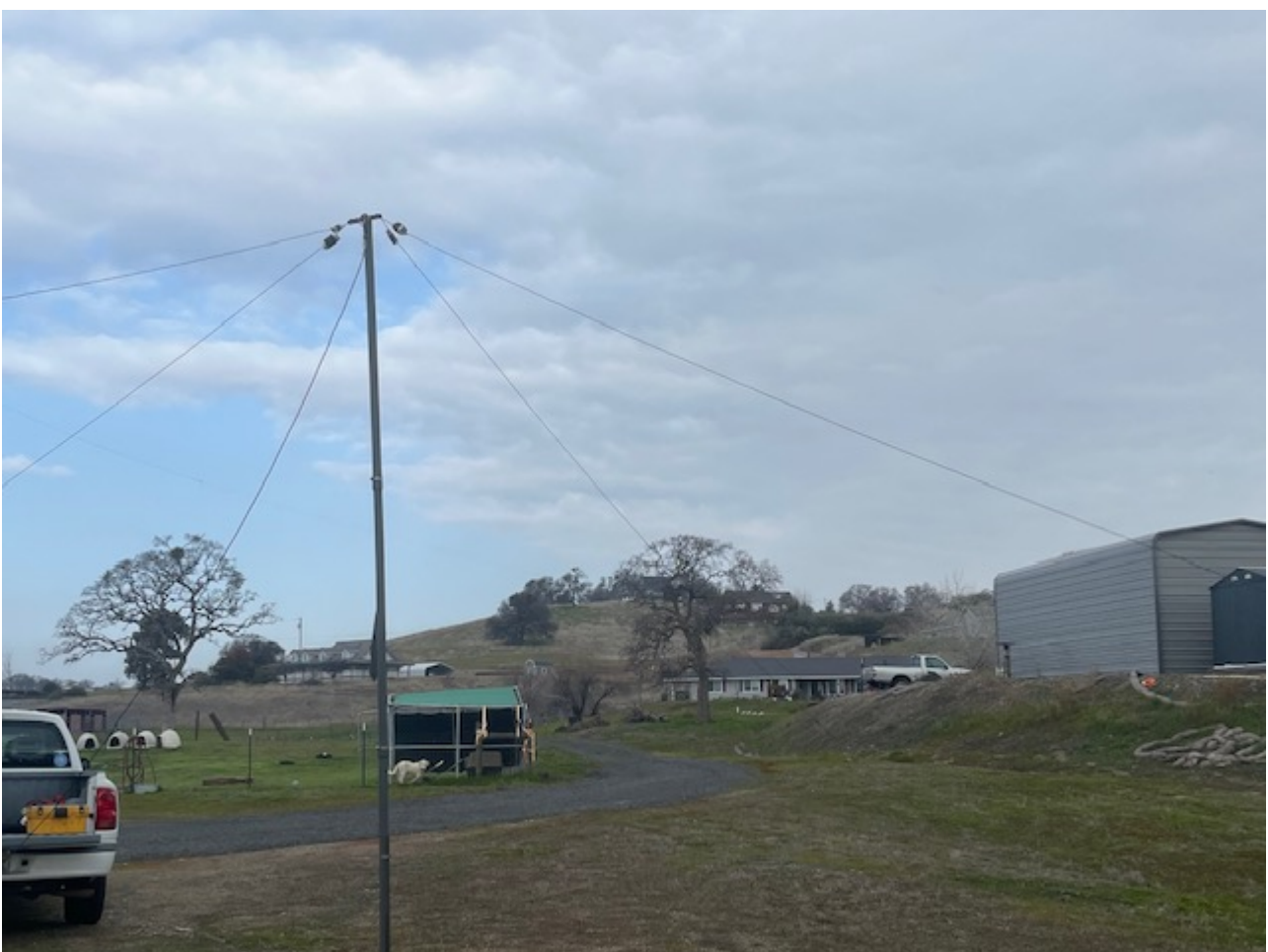
N6AXQ , NVIS Antenna
