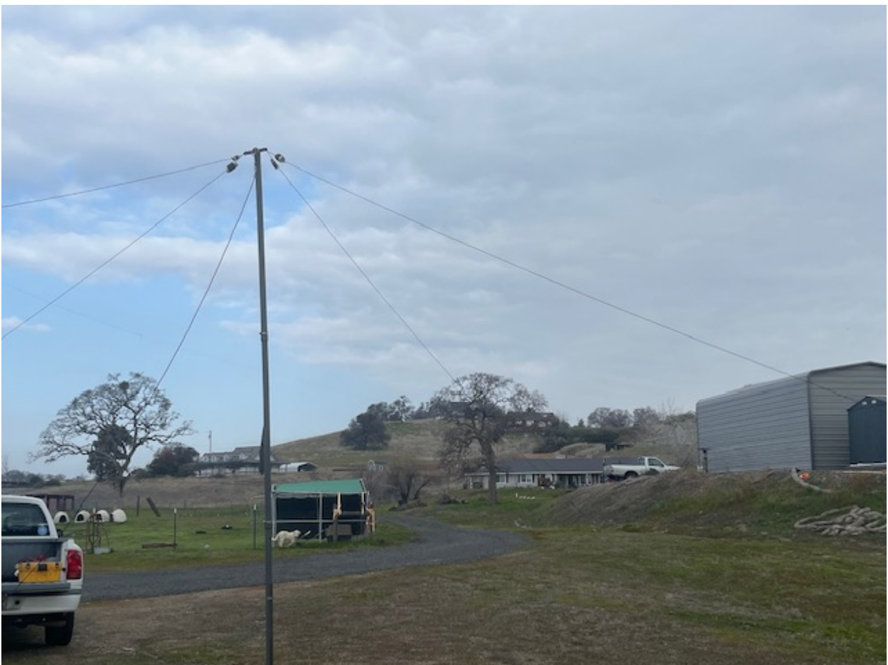
N6AXQ , NVIS Antenna
