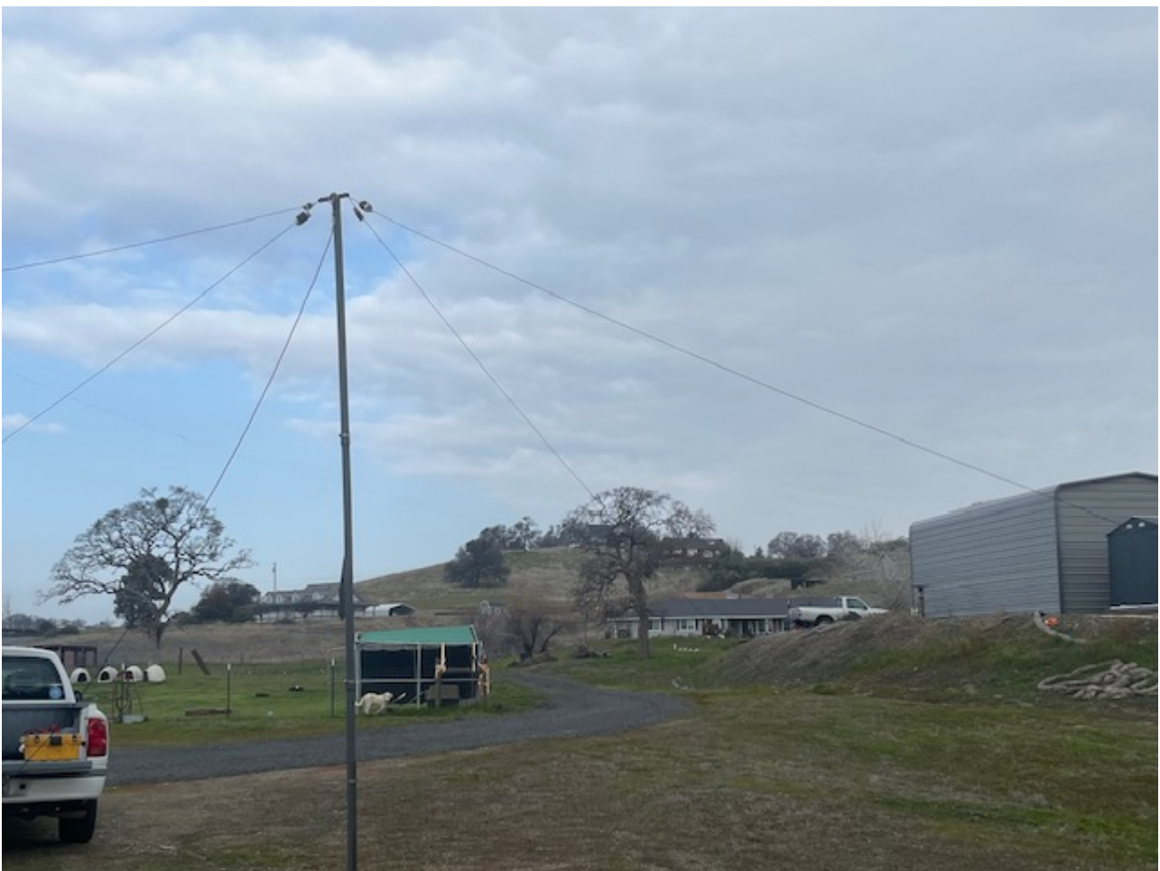
N6AXQ , NVIS Antenna
