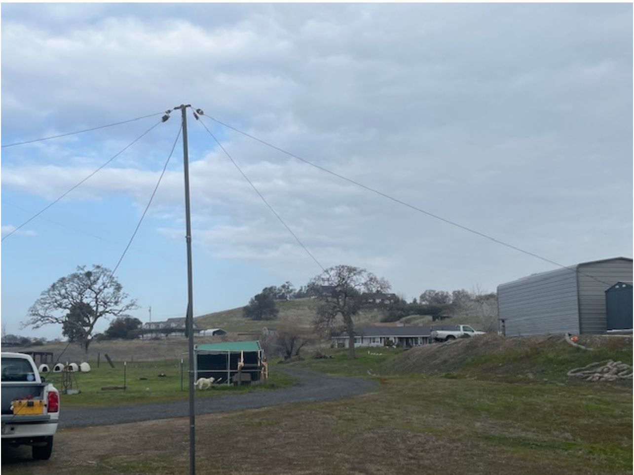
N6AXQ , NVIS Antenna
