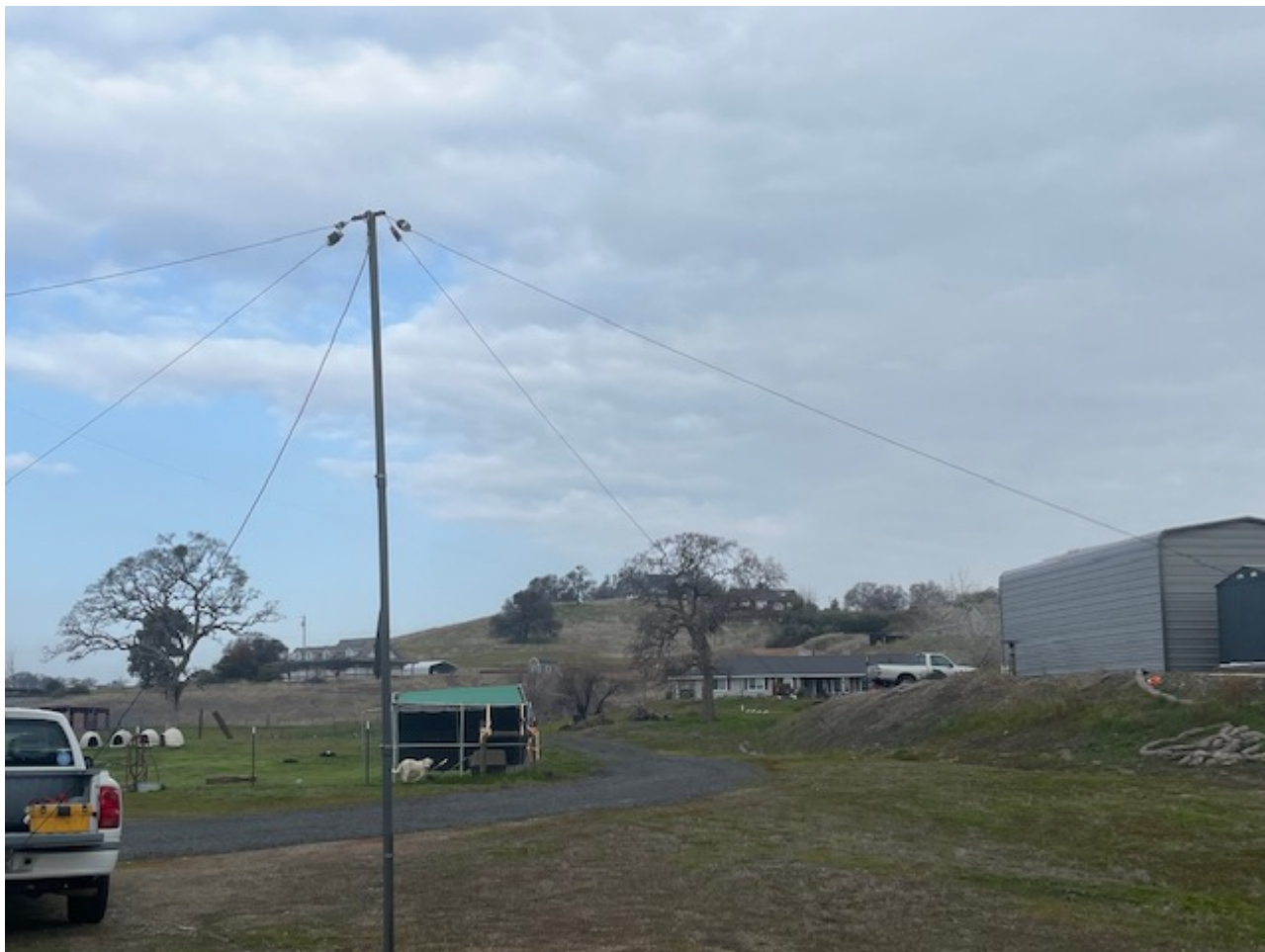
N6AXQ , NVIS Antenna
